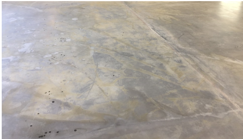
laiguline betoonpõrand peale masinpesu
